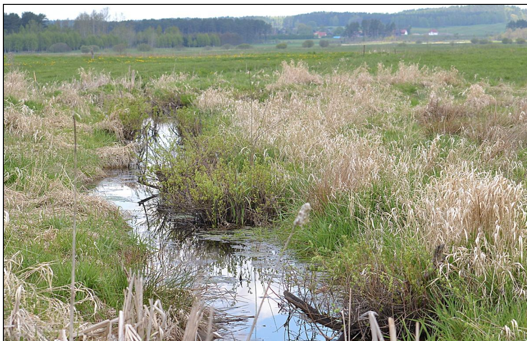
Fot. 1 Kanał melioracyjny Photo 1 The drainage ditch
