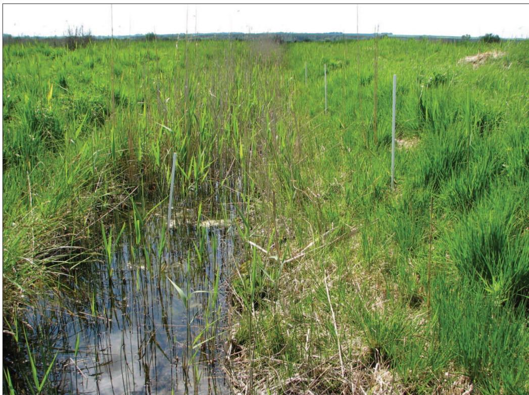
Fot. 5. Odcinek rowu po częściowym usunięciu ścioly i trzciny.
